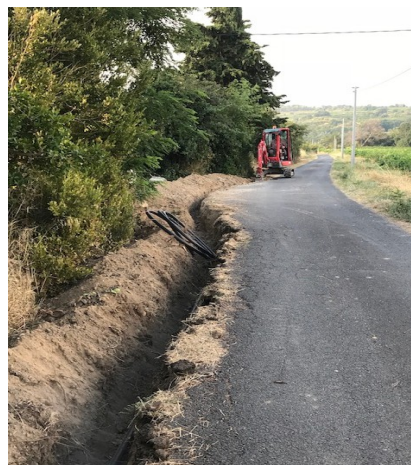
Les travaux d'acheminement de l'eau potable
